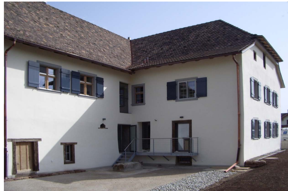
Dämmung mit Aerogelmatte, Quelle: AGI AG für Isolierungen
