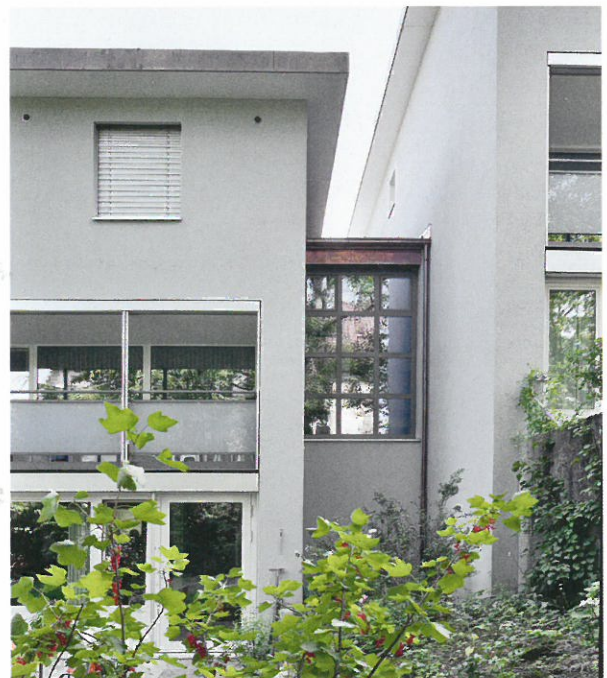
Das Treppenhaus erhielt anstelle der mit einzelnen Betonrahmen unterteilten Einfachverglasungen ein raumhohes Isolierglasfenster.
