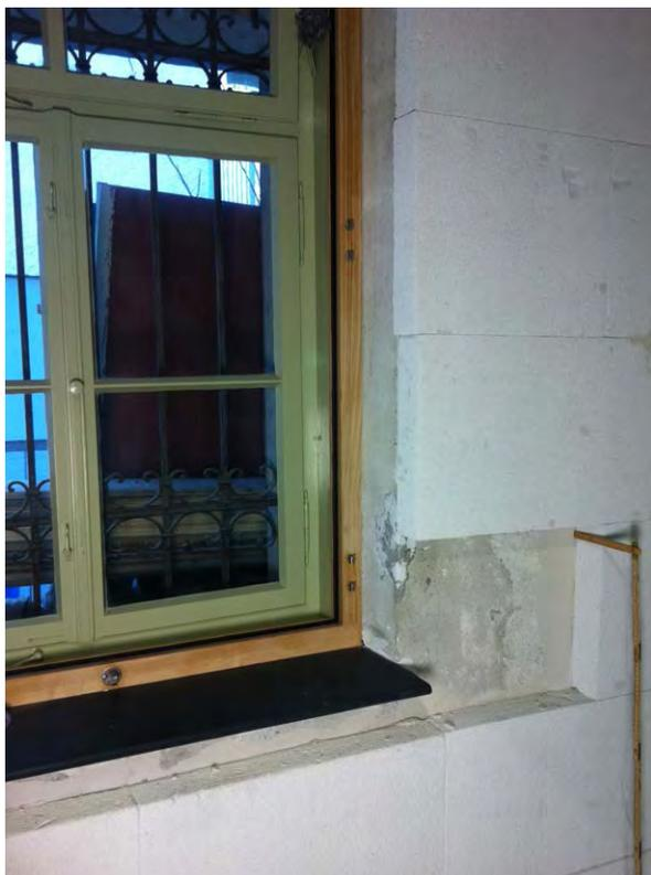
Reduzierte Innendämmung mit mineralischen Dämmplatten (Abb. 59)
