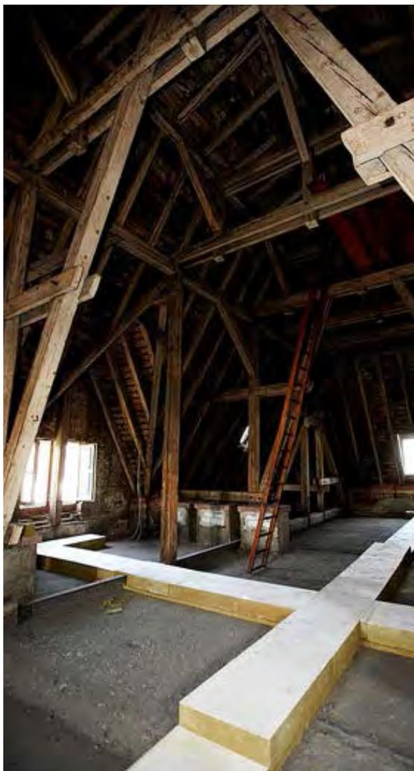
Spezialkonzept mit harter und weicher Dämmung: Willemer Schule Frankfurt von 1908, nicht begehrbar gedämmt, mit begehrbaren, hartgedämmten Wegen (Abb. 89)
