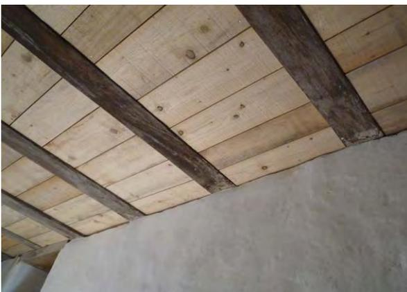
Gossau, Allenwinden, sorgfältig gedämmte Kellerdecke (Abb. 43)
