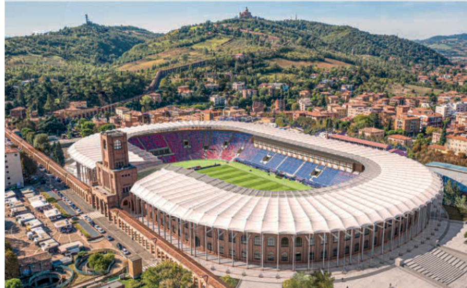
Visualisierung des Stadio Renato Dall'Ara in Bologna. Durch den Rückbau von Stahl wird der Backstein wieder sichtbar.
