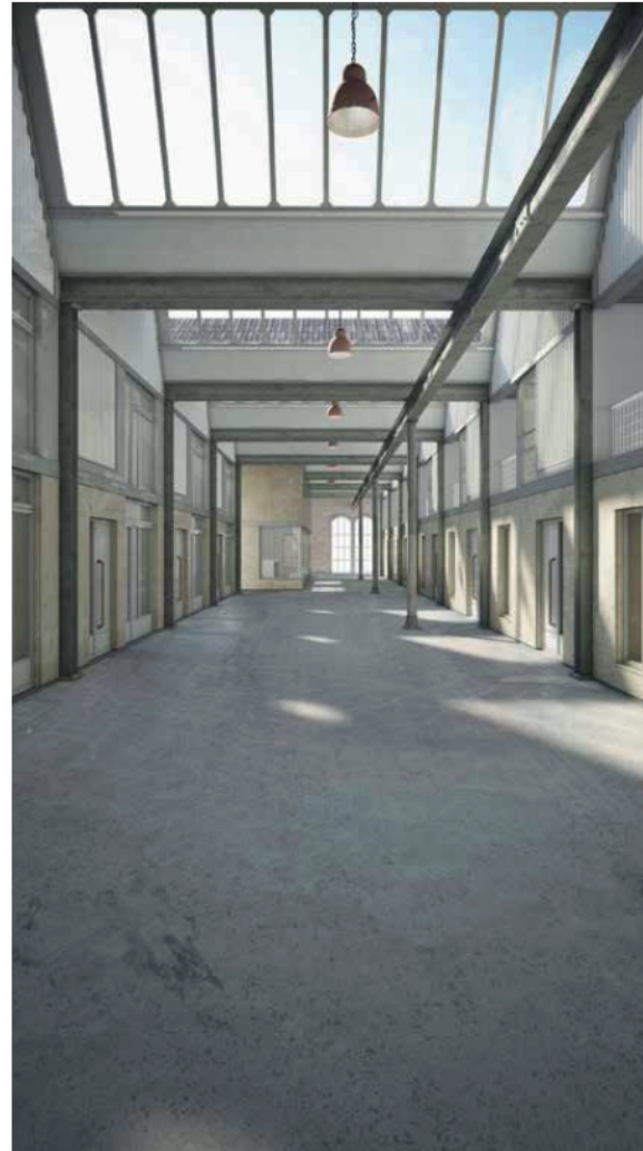
Die Shedhalle «Schappe» mit den eingebauten, von der Fassade abgelösten Räumen.
