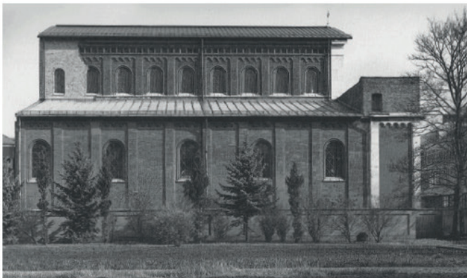
Façade ouest - Franz Peter & Franz Wimmer, Von den Spuren - interpretierender Wiederaufbau im Werk von Hans Döllgast, Salzburg, 1998
