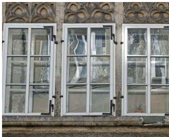
Vorfenster am gotischen Bürgerhaus Rue de la Samaritaine 16 in Fribourg (Abb. 10)
