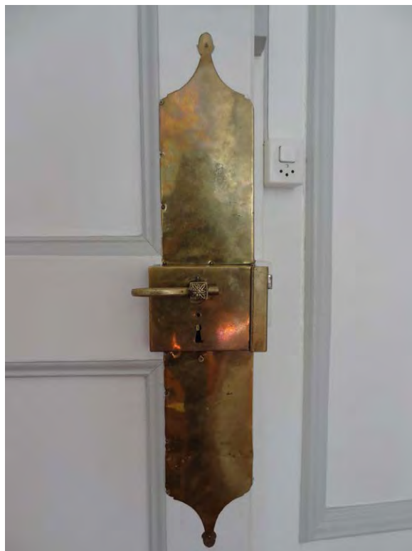
Klassizistisches Kastenschloss mit Langschild (Abb. 38)
