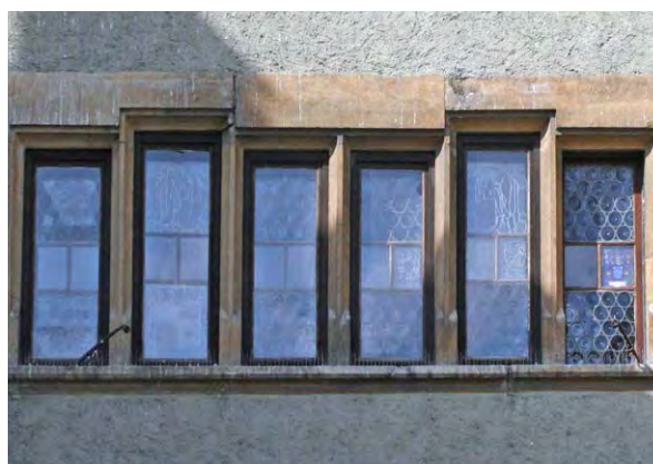
Altes Rathaus La Neuveville, Schutzverglasungen vor den Originalfenstern, ausgenommen das Fenster rechts aussen (Abb. 21)
