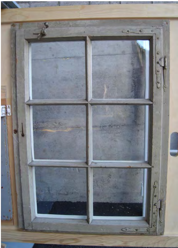
Musterfensterflügel mit Aussendoppel: Innenansicht (Abb.22)
