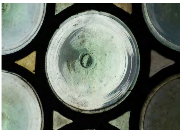
Detail einer Butzenscheibe mit mittlerer Butze (Abb. 15)
