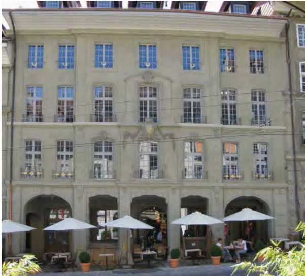
Gassenfront mit rekonstruierten Fenstern, Hotel Adler in Bern (Abb. 31)
