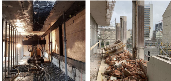
Rückbau tragende Fassade
