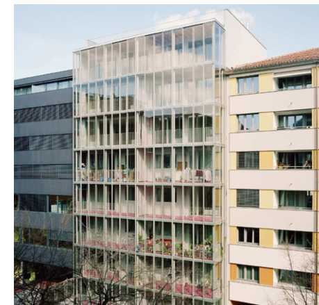
Hoffassade mit Wintergarten
