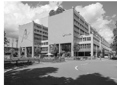
Ambassador House, Opfikon 1989 / 2014–2017 Stücheli Architekten (Gesamterneuerung)
