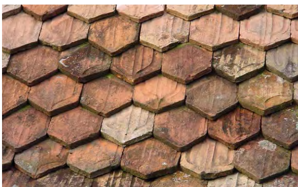
Ausschnitt Biberschwanzziegeldach Doppeldeckung (Abb. 7)
