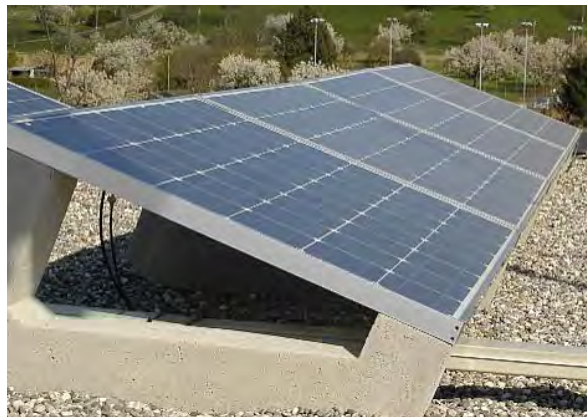
Voltaikolektoren auf Wohnhaus in Reihen (Abb. 39)
