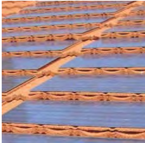
Lamine aus aufgelegten Dünnschichtmodulen (Abb. 22)
