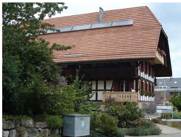
Thermische Kollektoren, Aufdachmontage, Gebäude an der Wangentalstrasse in Niederwangen (Abb. 30)
