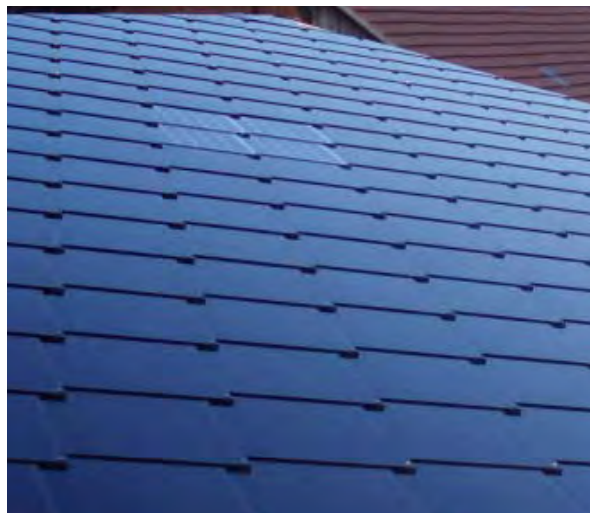
Solarschindeldach (Abb. 24)
