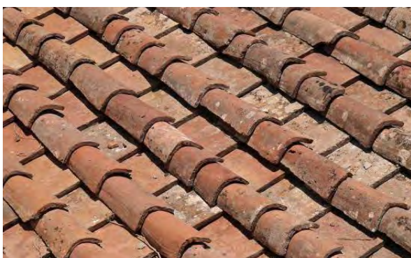
Dachausschnitt mit Klosterziegeln (Abb. 8)
