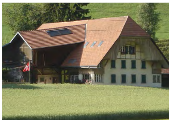
Kollektorenfeld für Warmwasseraufbereitung am untergeordneten Bauteil Hocheinfahrt, Bauerhaus in Hub, Gemeinde Krauchthal (Abb. 28)
