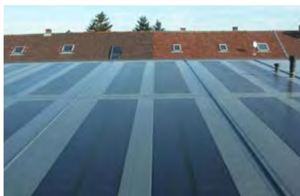
Dünnschichtlaminat als Voltaikolektoren und Dachhaut zugleich (Abb. 40)
