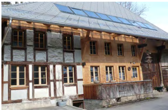
Indachmontage, Band mit Kollektoren und Dachflächenfestern, Gebäude an der Mühlestrasse in Münsingen (Abb. 29)
