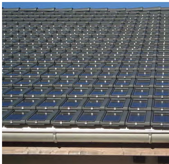
Solardachziegelsystem mit ziegelgrossen Voltaikerelementen (Abb. 21)
